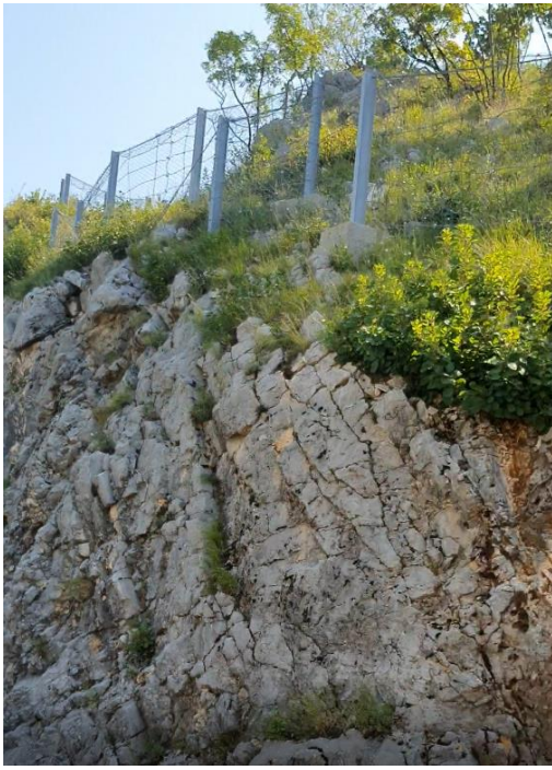
NEPROMIJENJENO STANJE; sanaciona mjera br. 7 (kosina prekrivena duplo uvijenom čeličnom mrežom, barijera po vrhu kosine)
