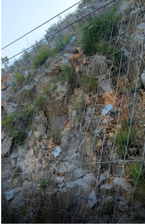
NEPROMIENJENO STANJE; Sanaciona mjera br.7 (barijera, SN ankeri, čelična mreža velike čvrstoće)
