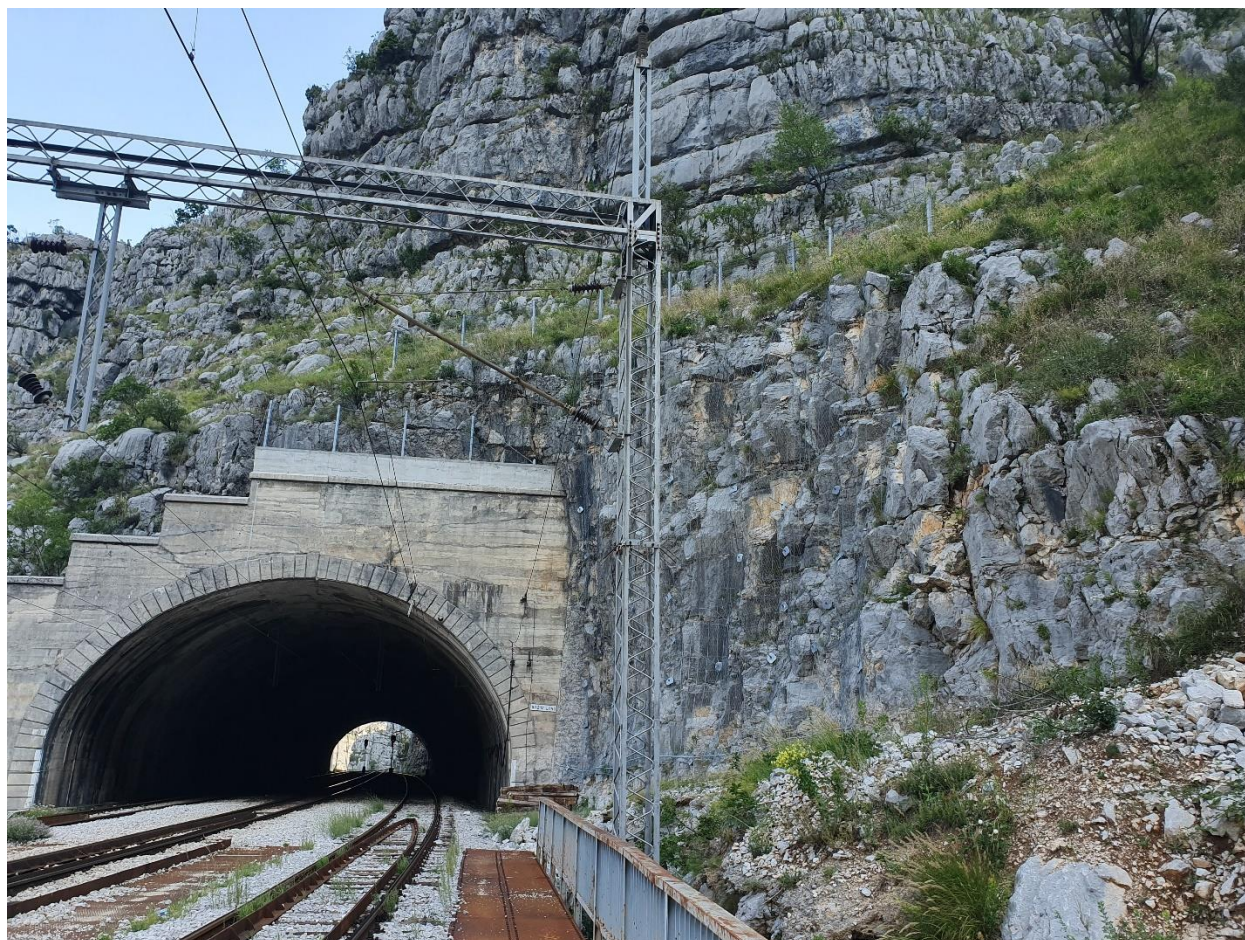
NEPROMIJENJENO STANJE; Izlazni portal tunela T212 (sanacione mjere br. 1 i 2)
