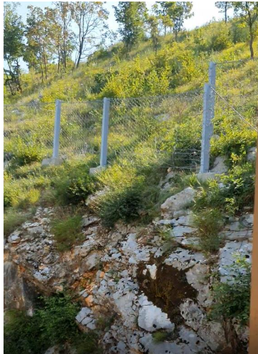
NEPROMIJENJENO STANJE; sanaciona mjera br. 7 (kosina prekrivena duplo uvijenom čeličnom mrežom, barijera po vrhu kosine)
