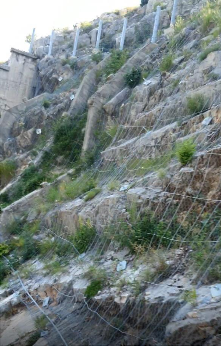
NEPROMIJENJENO STANJE; Sanacione mjere br.1 i br.2 (barijera, SN ankeri, čelična mreža velike čvrstoće)
