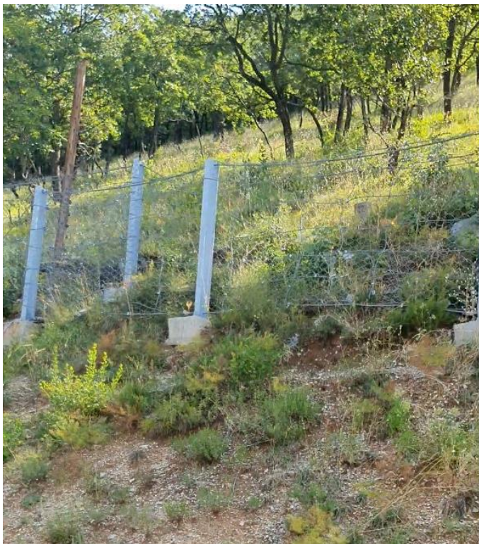
NEPROMIJENJENO STANJE; sanaciona mjera br.3 (barijera od čelične mreže velike čvrstoće po vrhu kosine)
