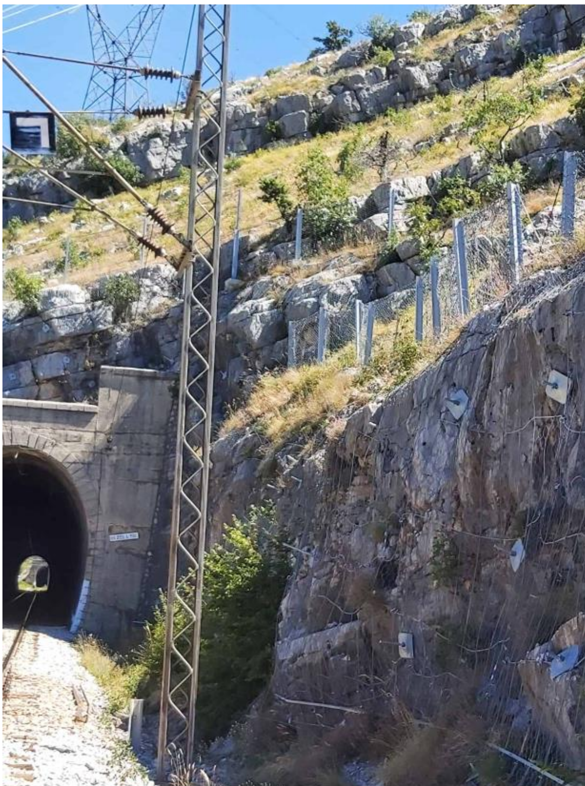
Foto.br.3.- Saniran potez barijere koji je oštećen odronjenim blokom dana 11.06.2020.godine (snimljeno 28.07.2020.godine
