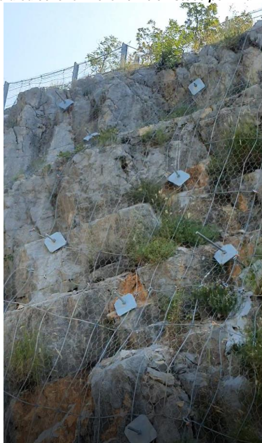
NEPROMIJENJENO STANJE; sanaciona mjera br.4 (barijera, SN ankeri, čelična mreža velike čvrstoće)
