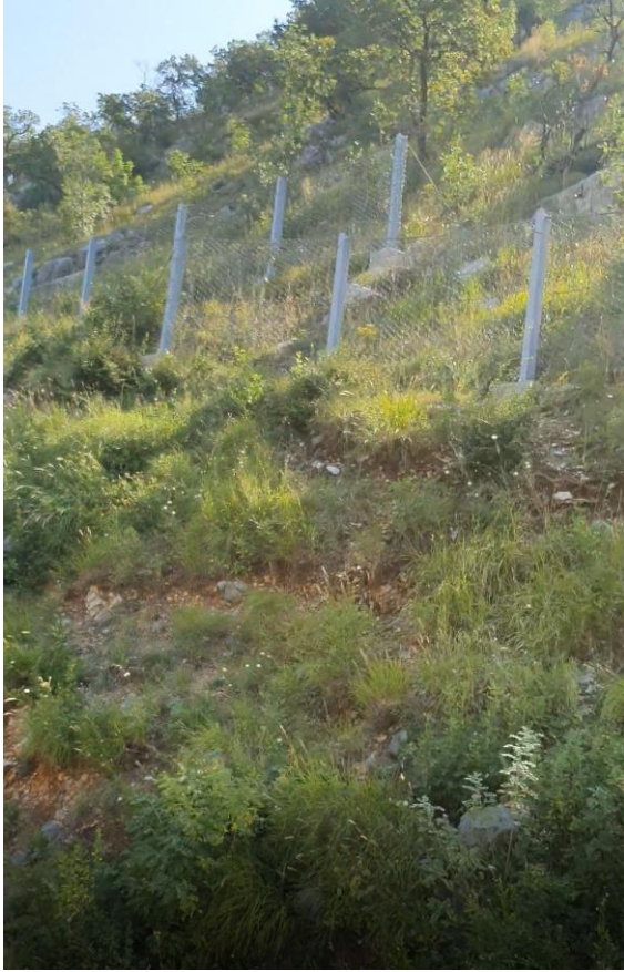
NEPROMIJENJENO STANJE; sanaciona mjera br.3 (barijera od čelične mreže velike čvrstoće po vrhu kosine)
