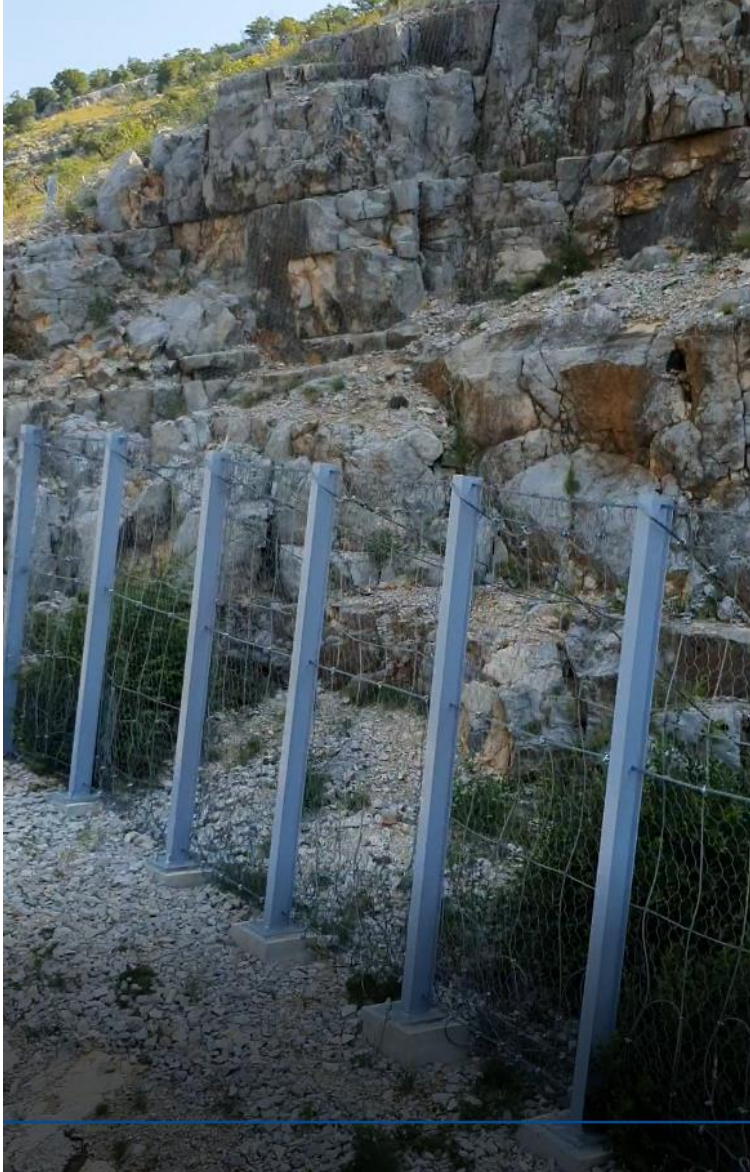
NEPROMIJENJENO STANJE; Sanaciona mjera br.5 (barijere od čelične mreže velike čvrstoće u podnožju kosine)
