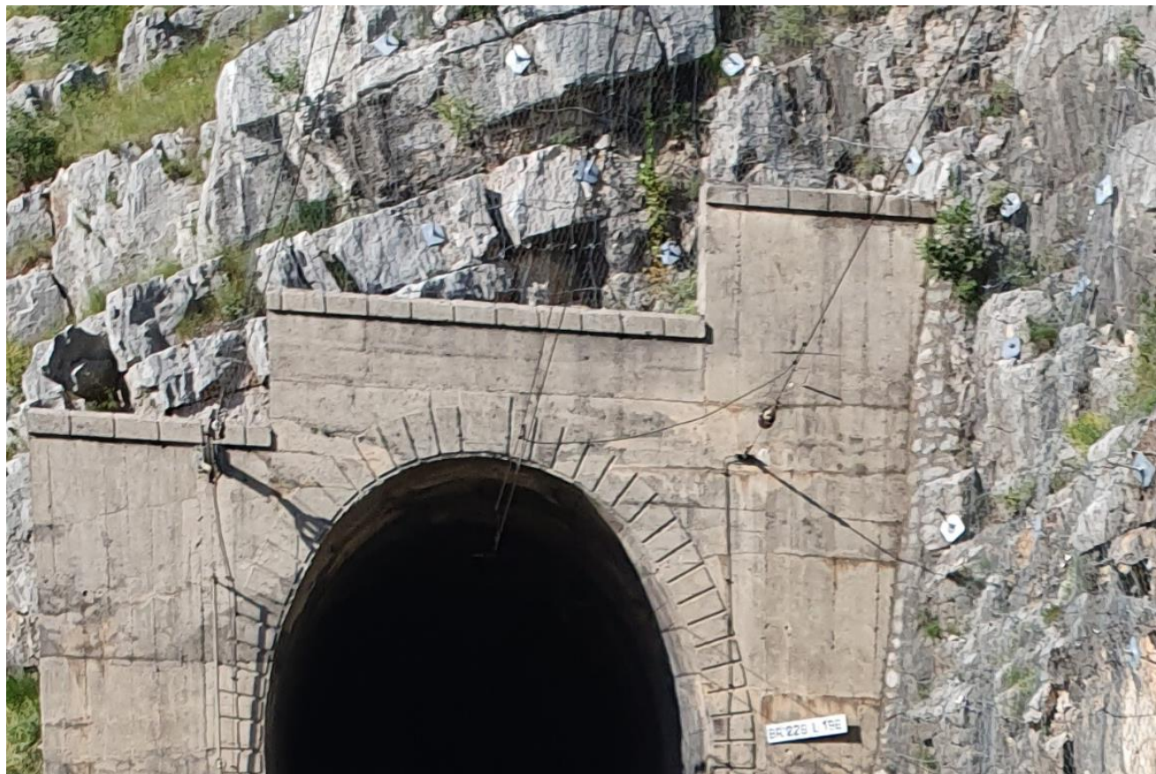
NEPROMIENJENO STANJE; Sanaciona mjera br.1 (SN ankeri i duplo uvijena čelična mreža)
