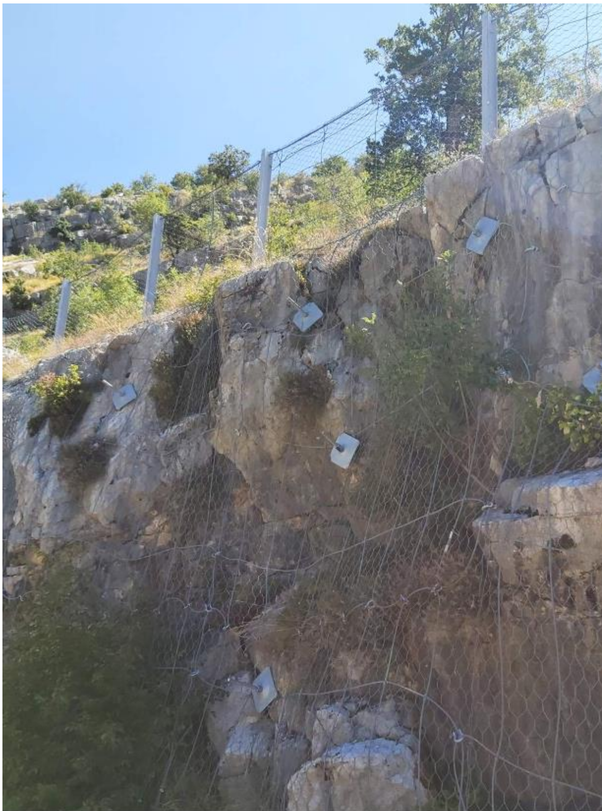
Foto.br.4.- Saniran potez barijere koji je oštećen odronjenim blokom dana 11.06.2020.godine (snimljeno 28.07.2020.godine
