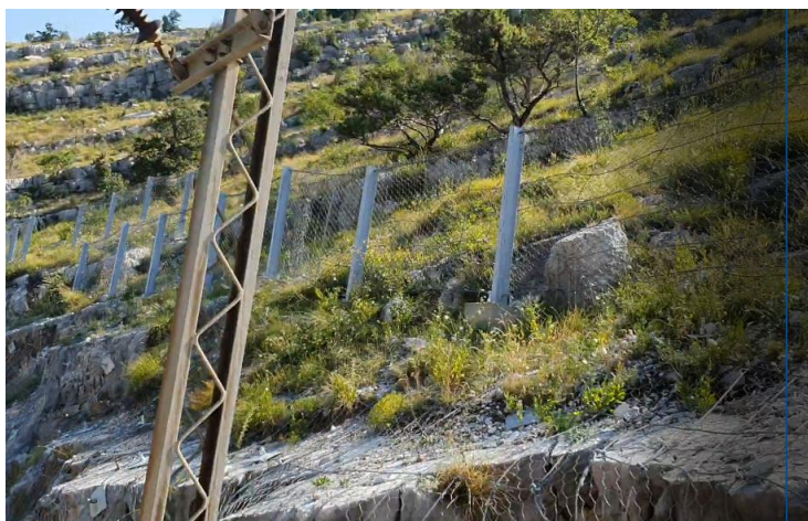
NEPROMIENJENO STANJE; Sanaciona mjera br.1 (SN ankeri i duplo uvijena čelična mreža)
