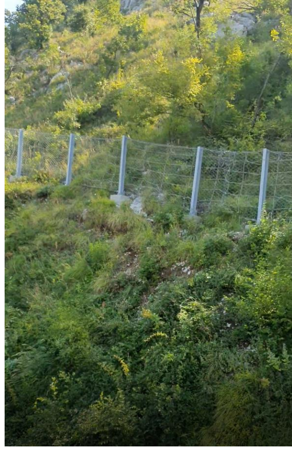
NEPROMIJENJENO STANJE; sanaciona mjera br.3 (barijera od čelične mreže velike čvrstoće po vrhu kosine)
