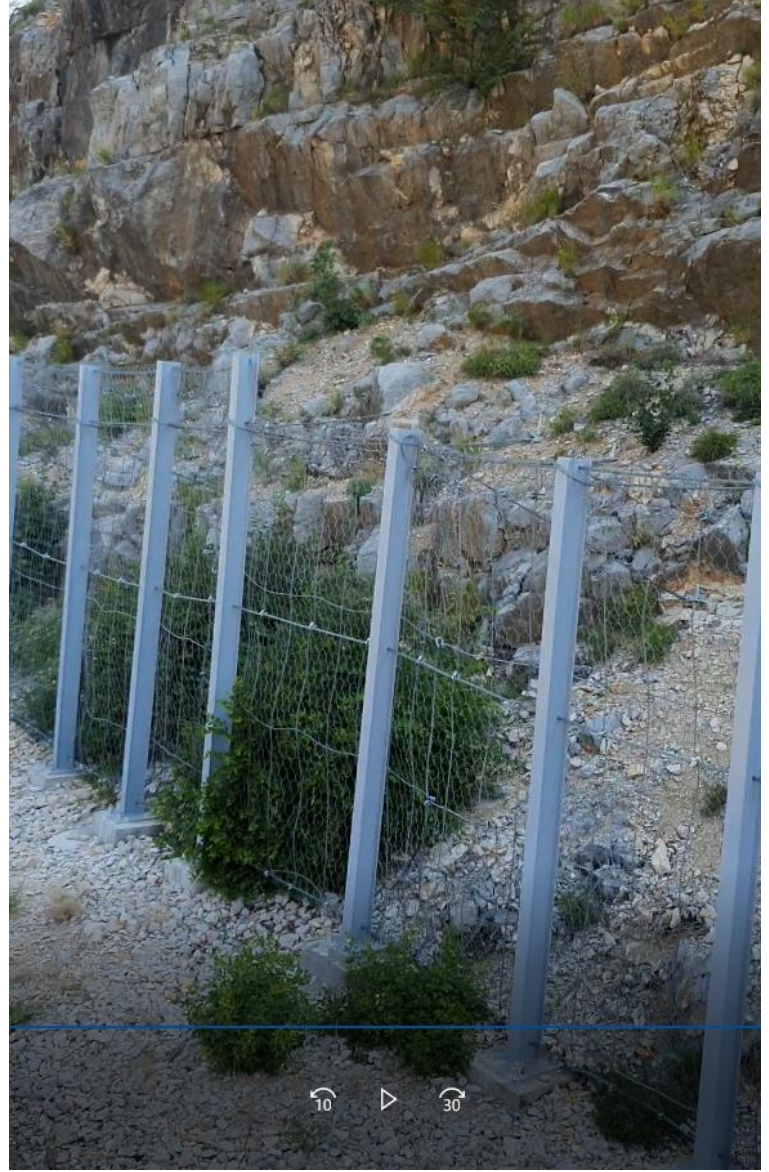
NEPROMIJENJENO STANJE; Sanaciona mjera br.5 (barijere od čelične mreže velike čvrstoće u podnožju kosine)
