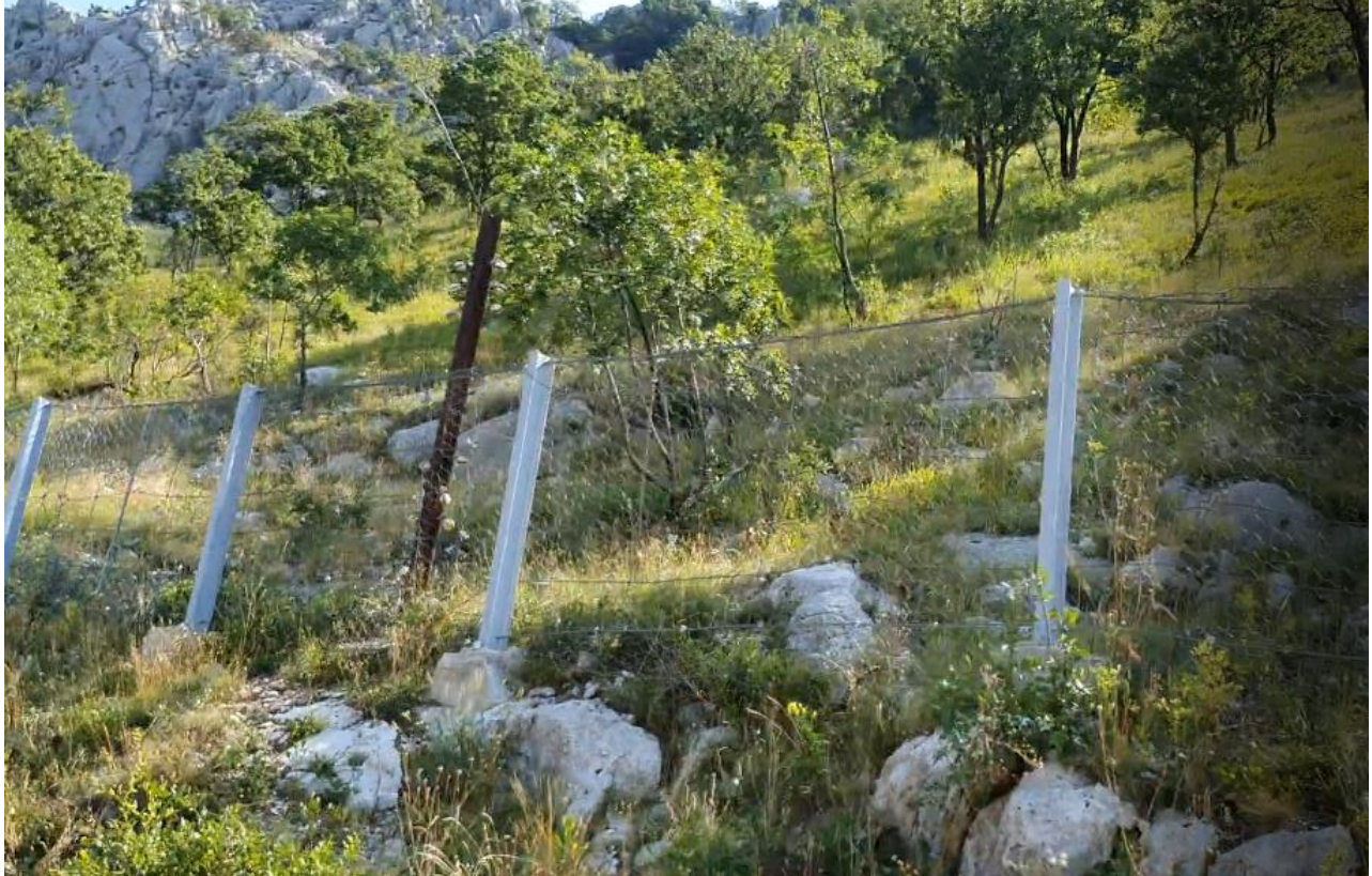
NEPROMIJENJENO STANJE; Sanaciona mjera br.5 (barijera od čelične mreže velike čvrstoće po vrhu kosine)
