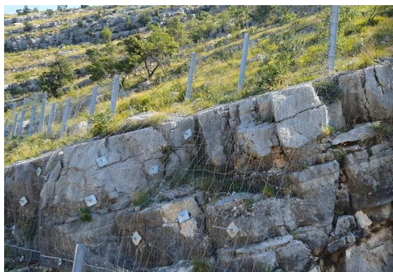
NEPROMIENJENO STANJE; Sanaciona mjera br.2, dio u nastavku koji nije bio ugrožen odronom od 11.06.2020.god. (čelična mreža velike čvrstoće, IBO i SN ankeri i barijera po vrhu kosine)
